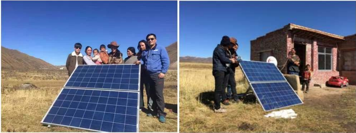
无电地区光伏项目现场审核
